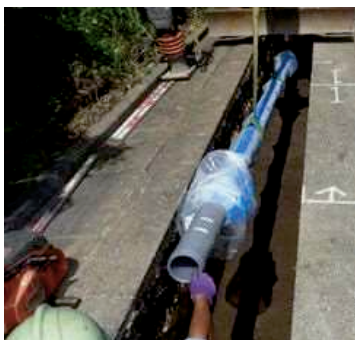
老朽管更新工事
